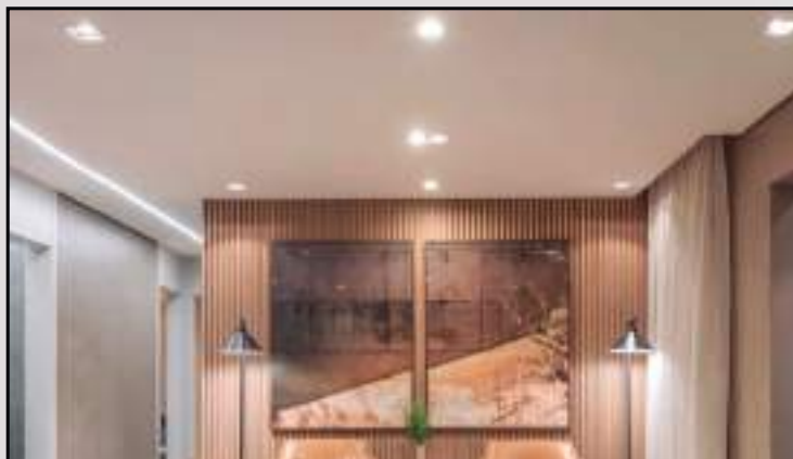
Teto rebaixado em gesso
